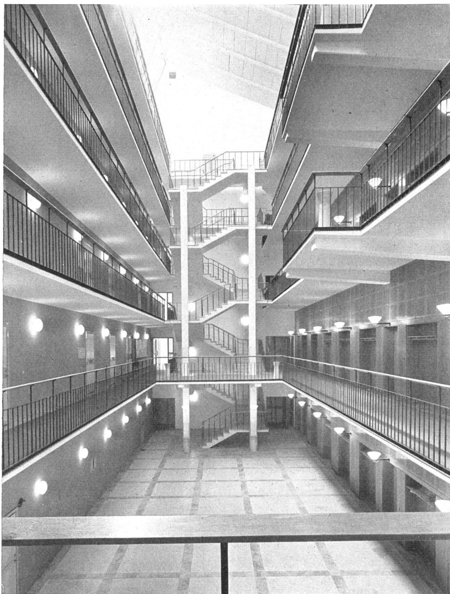
Lichthof mit Treppe und Galerien. Decke aus perforierten Eternitplatten mit dahinterliegenden schallabsorbierenden Steinwollmatten. Boden in Kunststeinmosaik zwischen Marmorfriesen | Cour vitrée, escalier et galeries | Covered court with staircase and galleries
