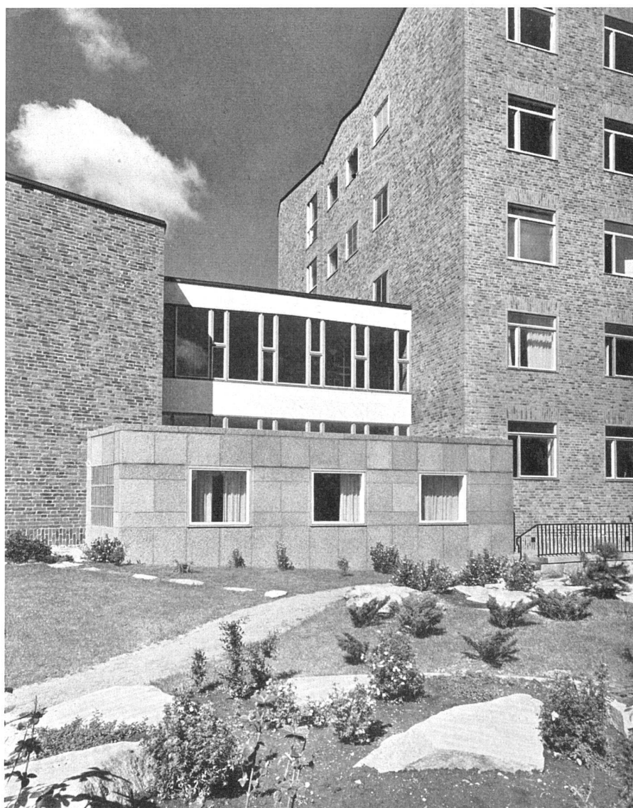
Verbindungsbau zwischen Hörsaal und Physikräumen. Weiß gestrichener Sichtbeton, rote Granitplatten zwischen Backsteinmauern | Bâtiment reliant l'auditoire aux salles de travail de l'école de physique | Connecting wing between lecture-room and physics laboratories
