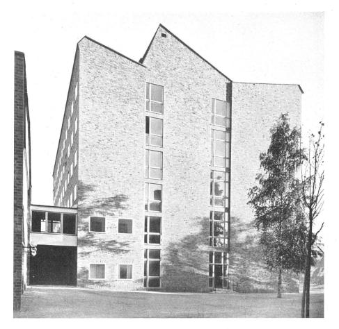
Verbindungsbau zwischen Hörsaal und Physikräumen. Weiß gestrichener Sichtbeton, rote Granitplatten zwischen Backsteinmauern | Bâtiment reliant l'auditoire aux salles de travail de l'école de physique | Connecting wing between lecture-room and physics laboratories
