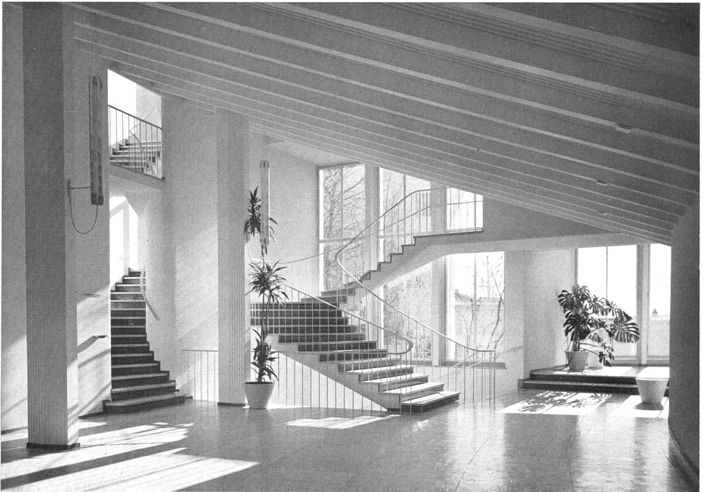
Vorraum. Treppen, Pfeiler und Decke in Sichtbeton, weiß gestrichen. Boden- und Treppenbelag in hellgelben Kalksteinplatten. Handlauf Anticorodal, Stäbe weiß gestrichen | Vestibule | Vestibule
