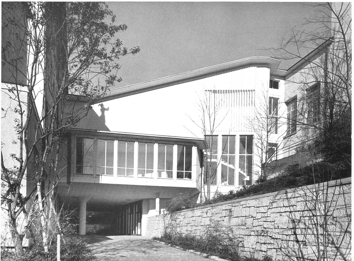
Der Hörsaal von Süden, zwischen altem Physikgebäude und Wasserbau-Labor eingebaut | L'auditoire vu du sud, entre la vieille Ecole de Physique et le Laboratoire de Constructions hydrauliques | Lecture room from South, built in between old Physics Building and Hydraulics Laboratory
