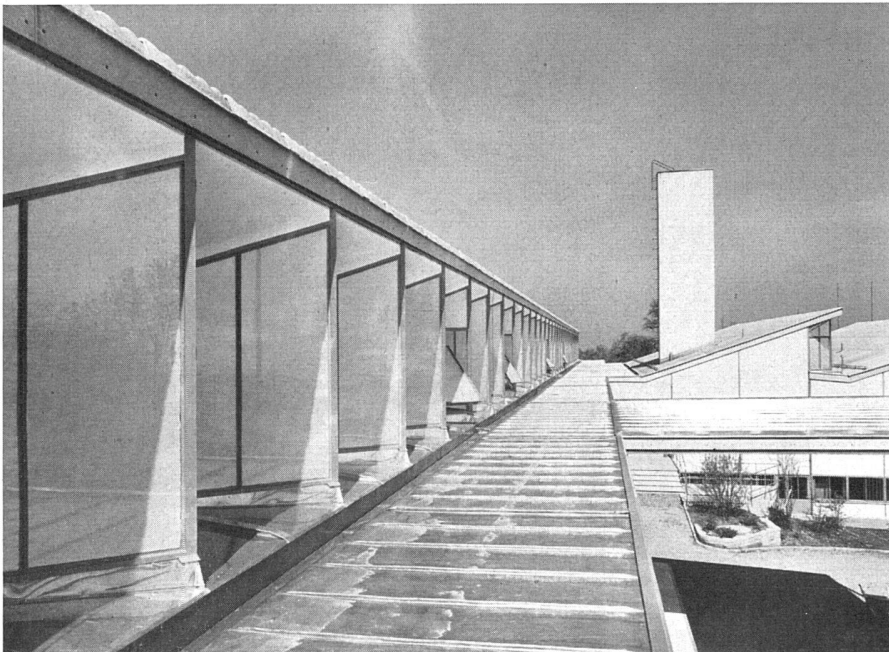
Magazin-Seitenlicht. Sheddächer in Wellteernit, Flachdächer in Aluman | Magasin; éclairage latéral | Stores' shed
