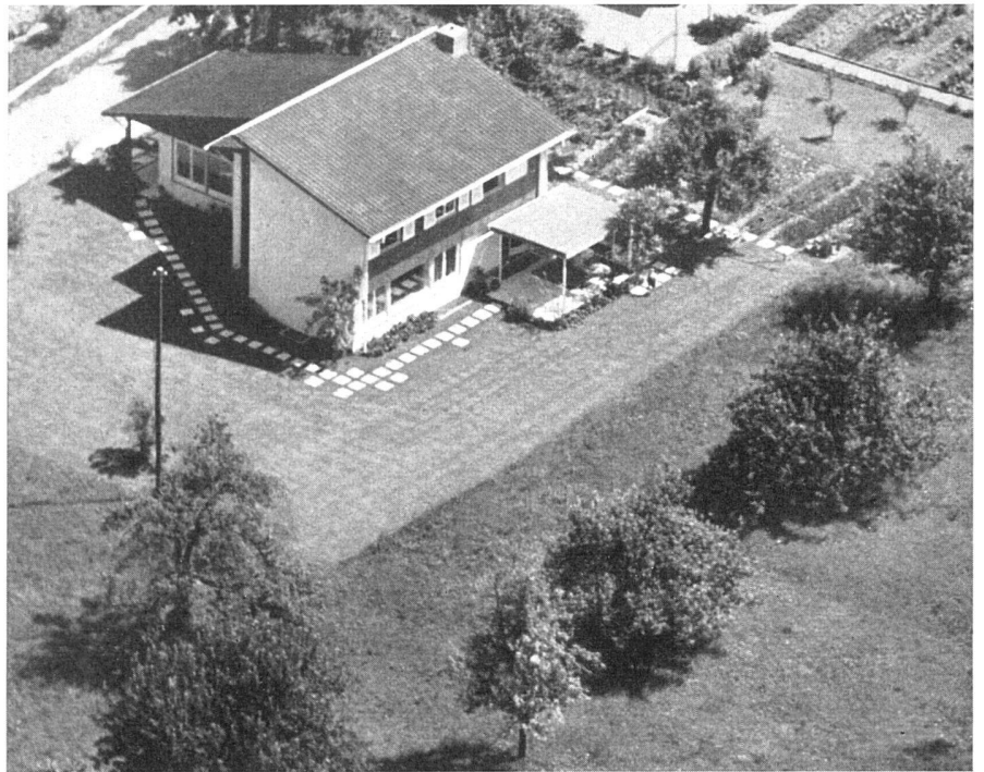
Flugaufnahme von Südwesten | Vue aérienne prise du sud-ouest | Aerial view from south-west Aerophoto AG., Winterthur
