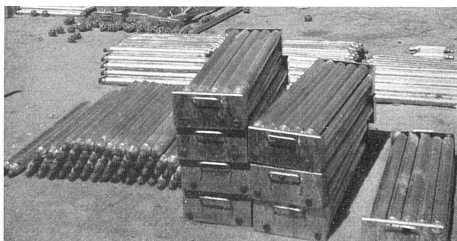
Die Rohrstäbe werden zum Transport zu Bündeln geschraubt, die Gewindkugeln in Kisten verpackt / Barres de l'ossature rangées en petits paquets en vue du transport / Some bundles of structural bars
