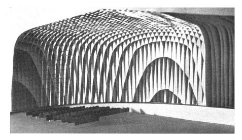
Kino-Innenraum, Wände und Decke aus Holzlamellen | Intérieur d'un cinéma, construction en lamelles de bois | Interior of a cinema, laminated wood construction
