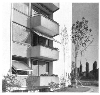
Seiten mit zusätzlicher Korkisolierung, Innere Tragwände in K.S. und Backsteinen 15-25 cm. Nichttragende Zwischenwände mit Zelltonplatten 6-8 cm. Decken: Eisenbeton, kreuzweise armiert, 16 cm stark. Treppen: Eisenbeton. Dach: Dachgesimse betoniert, frei ausdehnbar mit Kiesklebedach. Dachstuhl für Mitteldach in patentierter Holzkonstruktion, Pfannenziegeldach mit Schindelunterzug.
