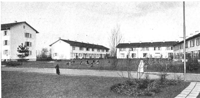
Siedlungsraum mit mäanderartig angeordneten Zeilen | Un des espaces libres de la colonie | Typical open area of the settlement
