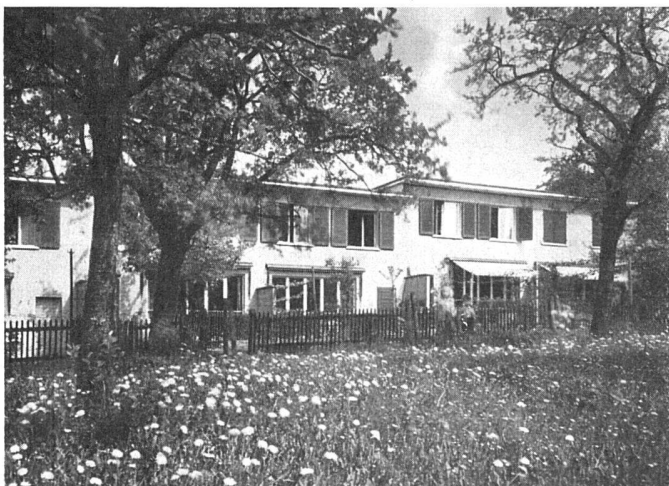
Reiheneinfamilienhäuser (A) 1931, Südansicht | Maisons du type cité-jardin construites en 1931, façade sud (A) | One-family row houses built in 1931 (A)
