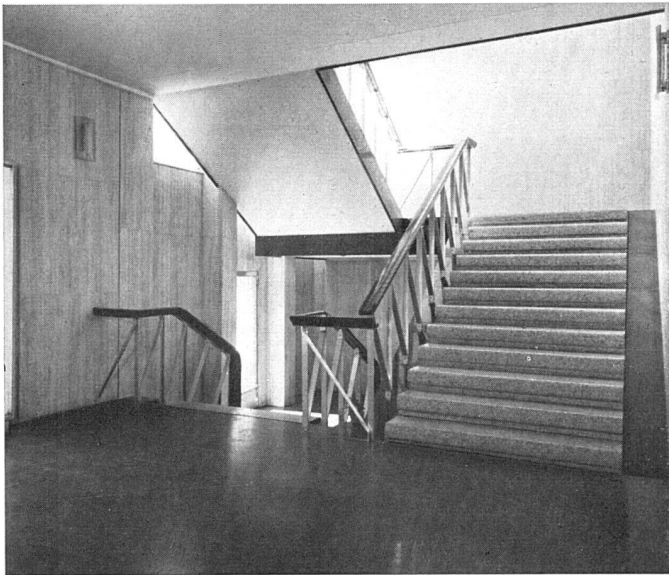
Treppe Vorderhaus. Boden und Treppenwangen in schwarzem Marmor, Stufen in geschliffenem hellem Granit, Geländer aus Aluminium, Wandverkleidung Travertin | Escalier de l'aile basse | Staircase of low wing
