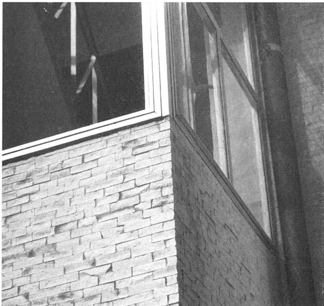
Fassadenverkleidung. Maschinengebrosene Carrara-Marmorstücke, 70 × 35 mm, 30 bis 50 mm tief | Les façades sont revêtues de petites pièces de marbre de Carrare | The elevations are clad with small pieces of Carrara marble
