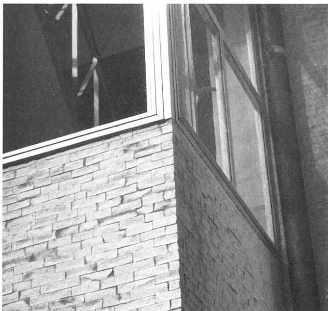
Fassadenverkleidung. Maschinengebrochene Carrara-Marmorstücke, 70 x 35 mm, 30 bis 50 mm tief | Les façades sont revêtues de petites pièces de marbre de Carrare | The elevations are clad with small pieces of Carrara marble
