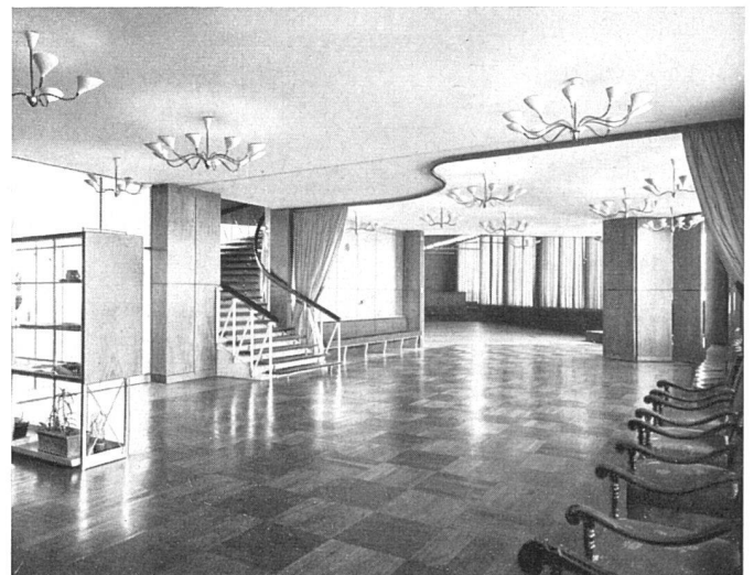
Vorraum mit geöffneten Falлтüren | Foyer aux portes pliantes ouvertes | Lobby with open folding partitions
