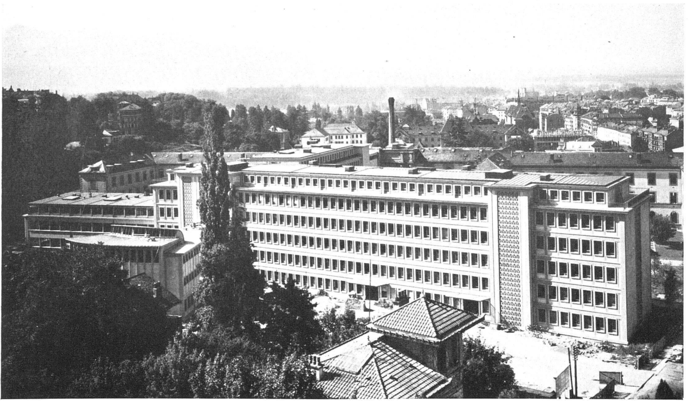
Façade nord-est du bâtiment des polycliniques, à g. l'auditoire | Nordostansicht des Polikliniktraktes, links der Hörsaal | The polyclinic wing from north-east, at l. the auditorium
