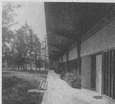
Vestiaires du stade de Champel G. Brera et P. Waltenspuhl, architectes FAS
