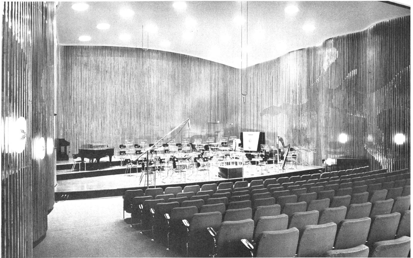
Rundfunkhaus Hannover. Musikstudio für mittleres Orchester mit 312 Sitzplätzen. Eingehängte Gipsdecke, Wandverkleidung aus nußbaumbraune Gaboon- und hellen Birkenstäben, darauf amöbenförmige Messingflächen, teilweise perforiert | Salle des concerts | The concert studio
