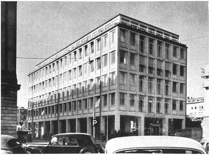
Gebäude der Basler Transport-Versicherungsgesellschaft in Frankfurt a. M. Eisenbetonskelett, Verkleidung mit Trasselfels-Kalksteinplatten. Lichtschonmaß 2,25 m. Arbeitsgemeinschaft G. Gottwald und G. Weber, Arch. BDA, Frankfurt a. M. | Bâtiment d'assurance | Insurance build- ing Photo: A. Pfau, Mannheim
