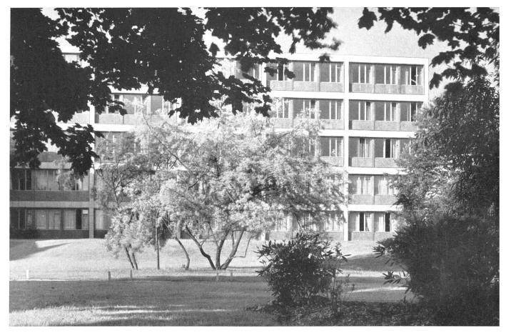
Westansicht des Nordflügels. Eisenskelettbau, Verkleidung mit gelbgrauem Tuffstein, Brüstungen mit rheinischer dunkelgrauer Basaltlava | L'aile nor (bureaux), façade ouest | West elevation of the northern office wing Photo: A. Pfau, Mannhei
