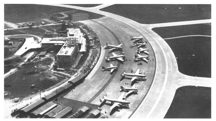
Bauzustand vom Mai 1952. Die Anlage soll auf Ende Jahr fertig werden. Der Passagiertrakt befindet sich im Zentrum in Querlage zum nähergelegenen Büro- und zum ferneren Restaurantstrakt, die parallel zum Flugsteig liegen, links außen Zu- und Wegfahrt | Etat des travaux en mai 1952 | Buildings in May, 1952
