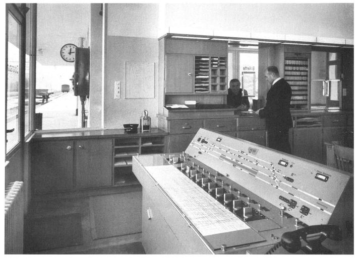
Das Stationsbüro als Zentrum der Kleinstation. Im Vordergrund das Pultstellwerk | Le centre de la petite gare en est le bureau; au premier plan, le tableau d'aiguillage | The station office as centre of the small station. Foreground, the signal-box controls
