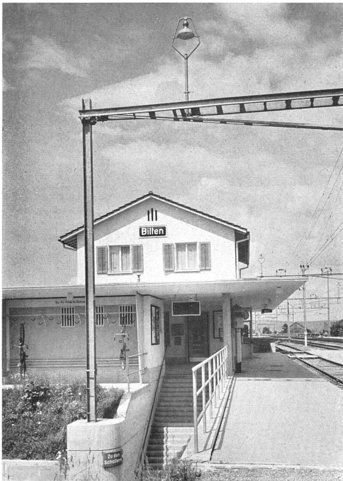
Ansicht von Osten mit Aufgang von der Straßenunterführung | Vue prise de l'est et escalier conduisant au passage souterrain | View from East with steps from street subway
