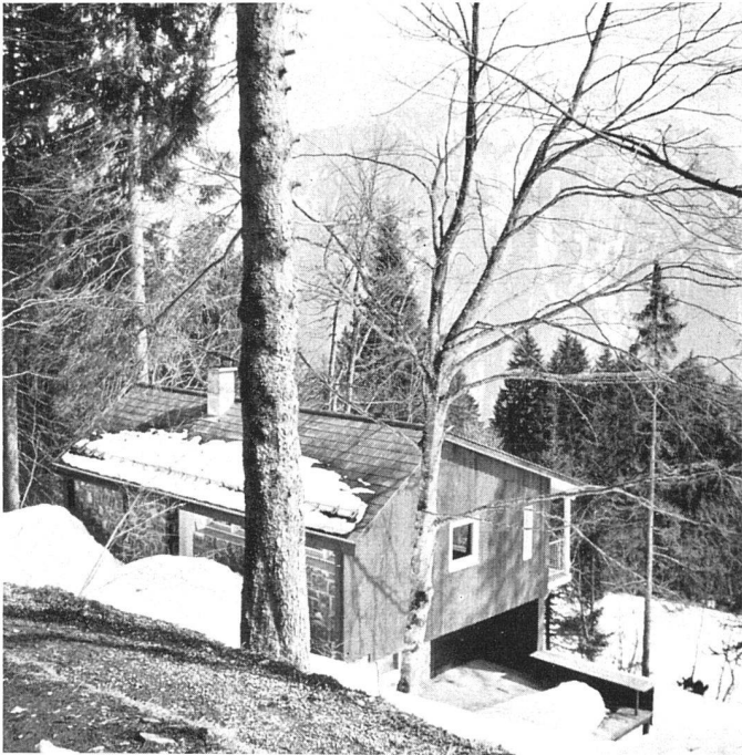
Rückansicht, Dach mit Eternitschiefer gedeckt | La maison vue d'en haut | Back view
