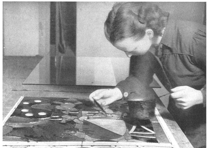
7 Aufwachsen der Glasstücke mittels Wachstropfen | Assemblés sur une plaque de verre simple, les morceaux de verre y sont fixés avec de la cire liquide | The pieces of glass, fixed with wax, are assembled on plain glass
