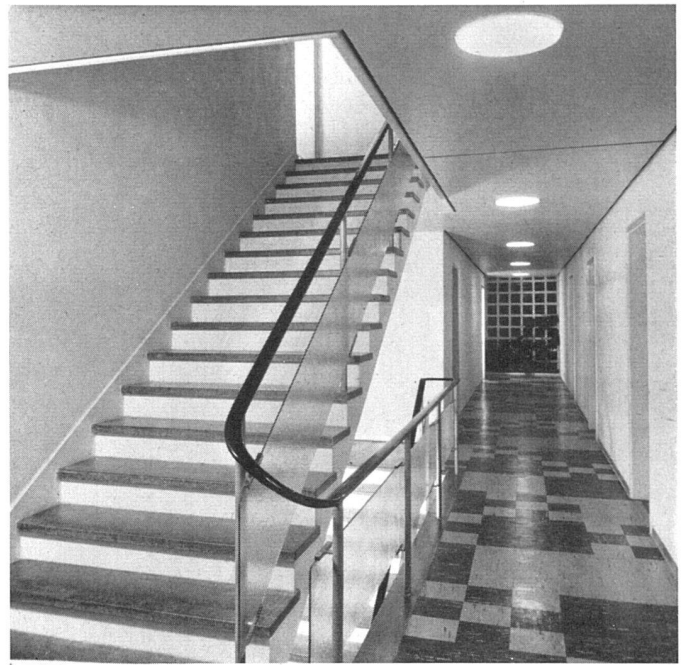
Korridor und Treppe im 1. Obergeschoß. Bodenbelag schwarze und hellgraue Asphaltplatten, Wände weiß, Decke hellblau. Treppengeländer mit schwarzem Handlauf und roten Stützen | Corridor et escalier, au premier étage | Corridor and staircase in first floor
