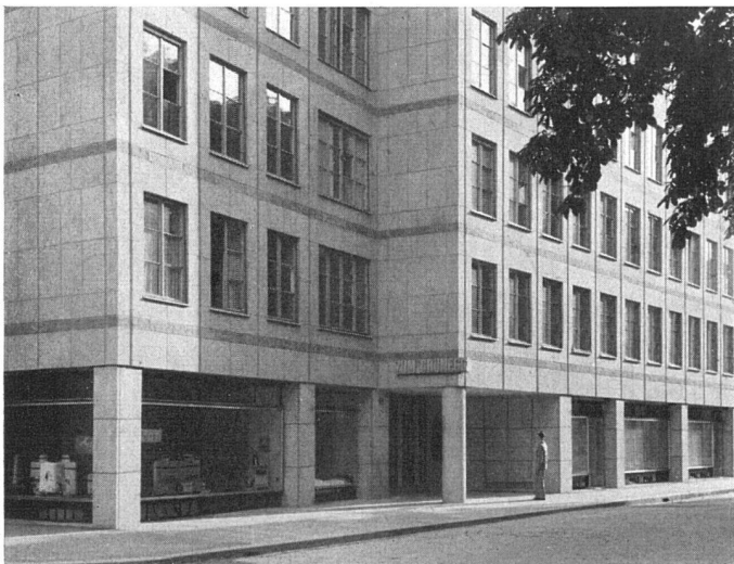
Fassadendetail Ecke Talstraße/Bären-gasse | Détail de la façade | Elevation detail
