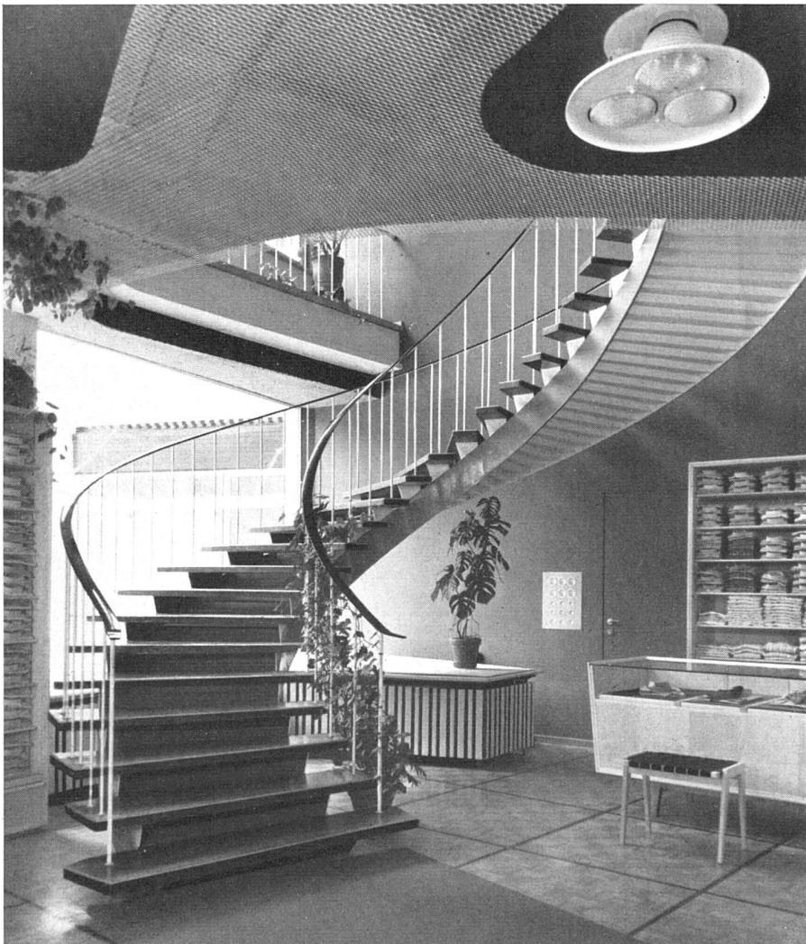
Interne Treppenanlage. Eisentreppe, aufgesetzte Holzstufen mit schwarzem Gummiüberzug. Untersicht weiß | Escalier interne | Internal staircase
