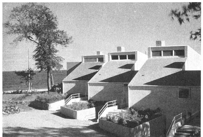
Ansicht von Nordwesten mit Hauseingängen | Vue prise du nord-ouest et montrant les entrées | From north-west with house entrances
