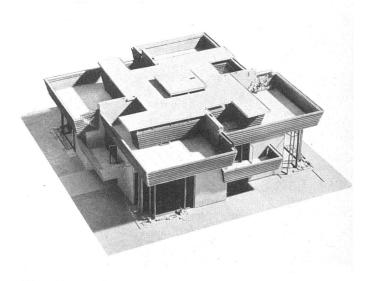
Abb. 3. Terrassenhäuser «Suntop Homes» in Ardmore, Penna., USA, 1939. Fr. Ll. Wright. Die windgeschützten Dachterrassen sind eine Kompensation für die ungleichwertige Orientierung der Häuser | Les toitsterrasses compensent l'orientation inégale de ces quatres maisons formant un tout; maquette | Model of the four «Suntop Homes»
