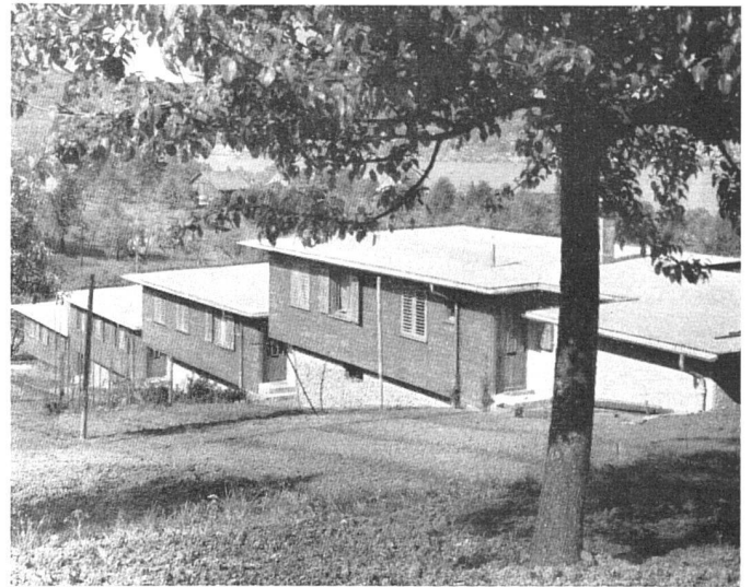
Abb. 2. Senkrecht zum Hang gestellte Zeilen geben freien Blick in die Landschaft. Siedlung Gwatt, Wädenswil, 1944, H. Fischli und O. Stock, Arch. BSA, Zürich | Cité jardin à plan ouvert avec vue libre sur le paysage | Row-houses arranged perpendicularly to the slope give free view towards the landscape Photo: Froebel SWB, Zürich
