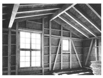
Der Innenraum im Bau. Das Dach ist mit 5 cm dicken Perfectaplatten isoliert, die Wände außen mit solchen von 3 ½ cm. Auf die Innenseite der Wände kommt noch eine zweite Isolierschicht aus Perfectaplatten 1 cm dick | L'intérieur en voie de construction | The interior under construction
