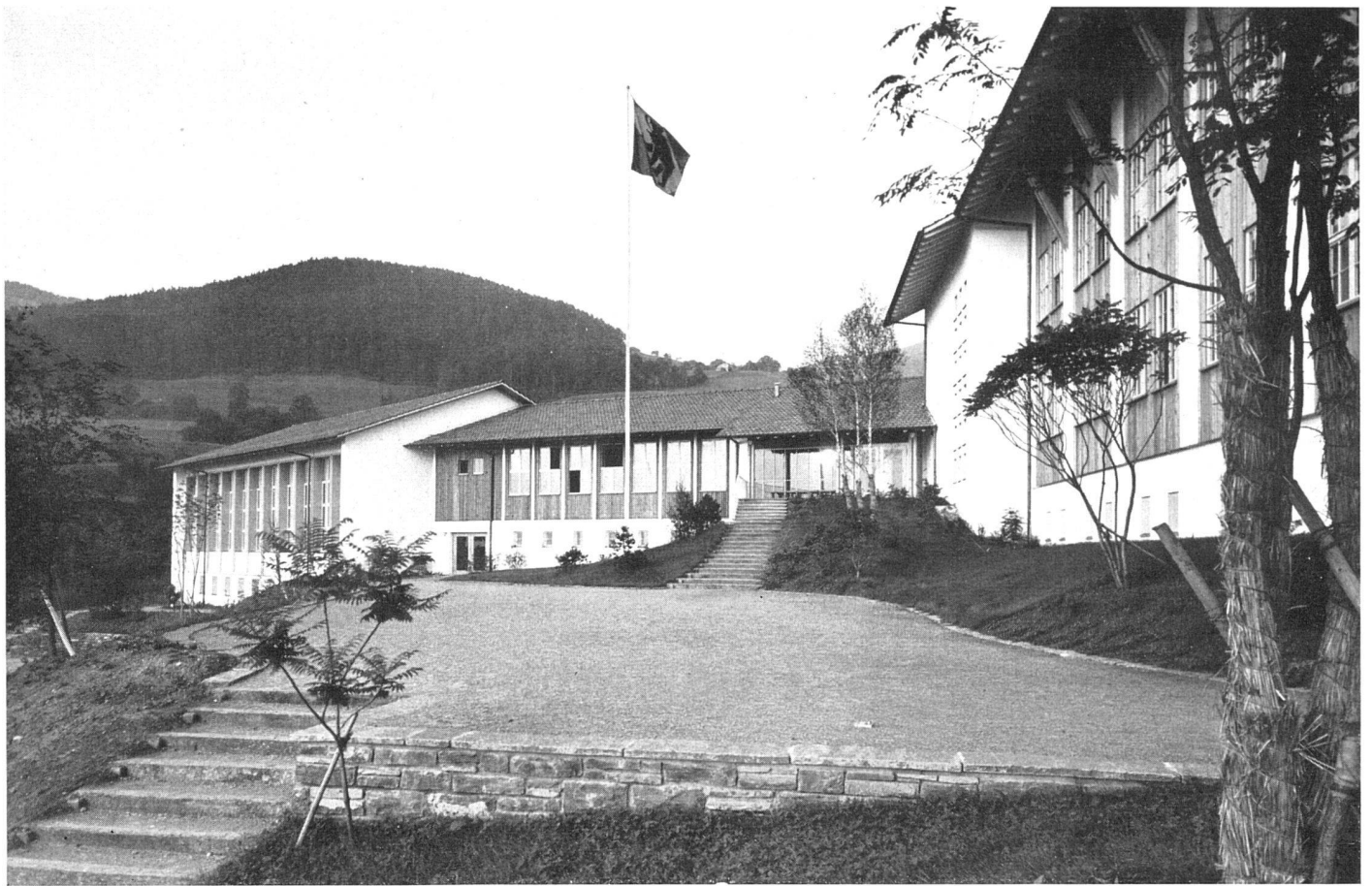
Gesamtansicht von Westen, links außen die Turnhalle | Vue d'ensemble prise de l'ouest | General view from west, at left the gymnasium
