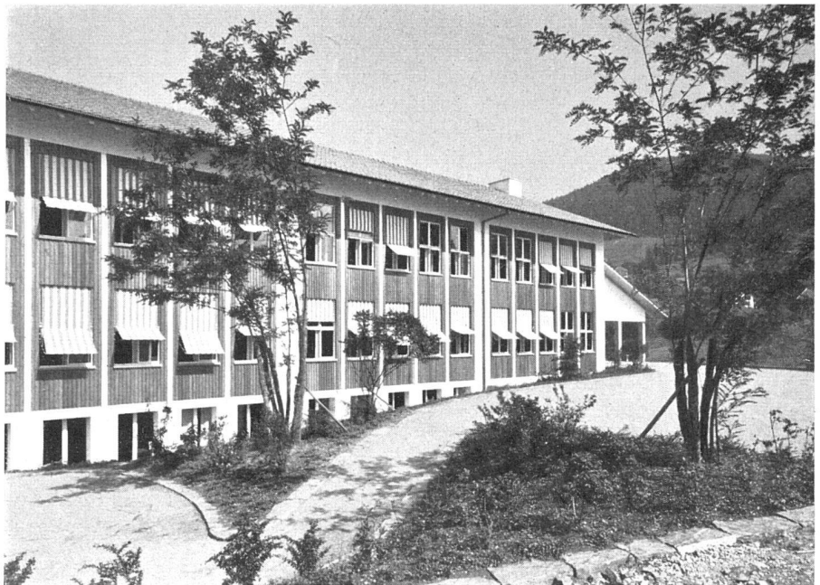
Der Klassenflügel von Süden, Wandfüllung aus Holz | L'aile des classes vue du sud | The classroom wing from south
