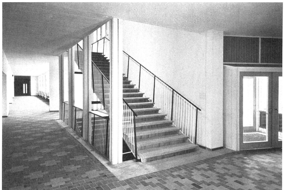
Korridor mit Treppenaufgang | Corridor et escalier | Corridor and stair case
