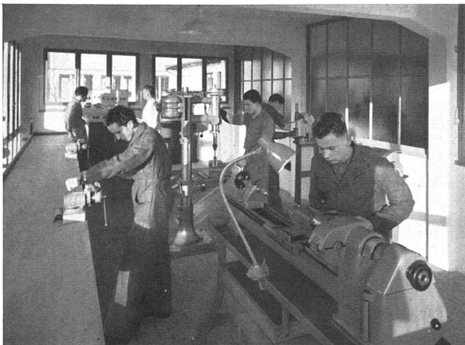
Metallwerkstätte (Erdgeschoß) | Atelier pour travaux sur métaux (rez-de-chaussée) | Metal workshop (ground floor)
