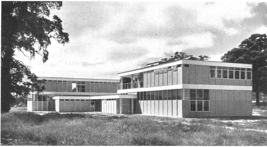
Sekundarschule in Clarendon, Hertfordshire. Außenwände aus vorfabrizierten 3 cm starken Plastikplatten, Stahlskelett. Architekturbüro der Grafenschaft Hertfordshire, Aslin, County Architect | Ecole secondaire faite de panneaux préfabriqués en plastic | Clarendon Secondary School made of prefabricated plastic panels Holoplast
