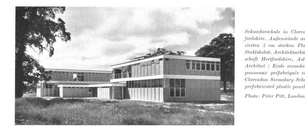
Sekundarschule in Clarendon, Hertfordshire. Außenwände aus vorfabrizierten 3 cm starken Plastikplatten, Stahlskelett. Architekturbüro der Grafschaft Hertfordshire, Aslin, County Architect | Ecole secondaire faite de panneaux préfabriqués en plastic | Clarendon Secondary School made of prefabricated plastic panels Holoplast
