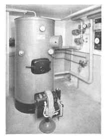
Kombinierte Ausführung für Heizung und Warmwasserbereitung
