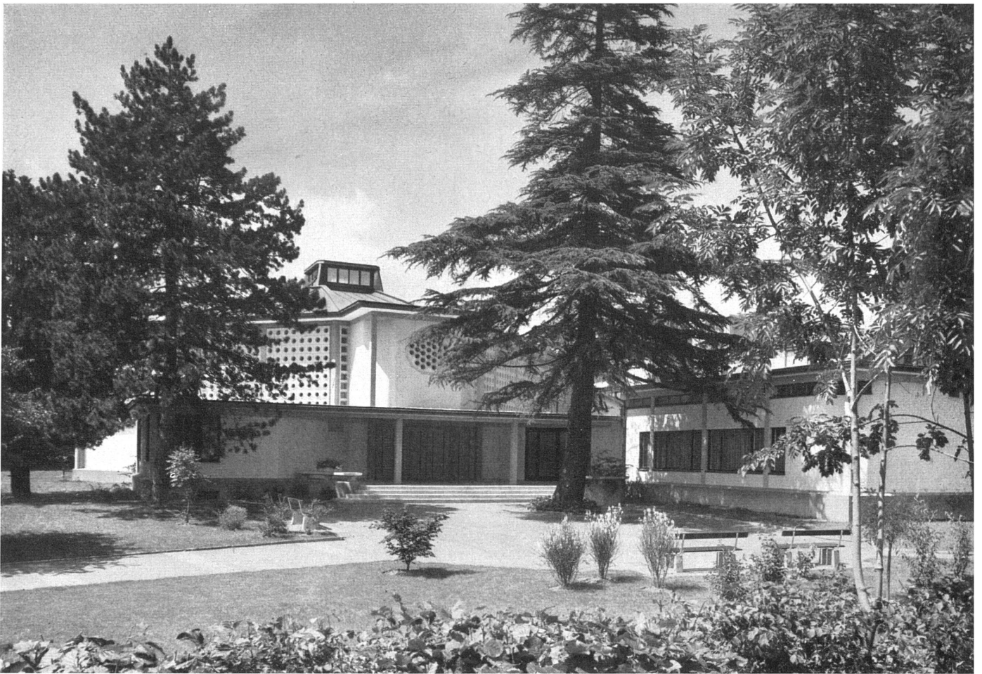
Gesamtansicht von Süden mit Kirchenvorplatz | Vue générale prise du sud | General view from south
