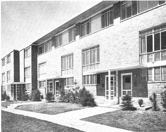
Mietwohnungen in Washington D. C. 1948, mit privater Finanzierung. Architekten: Berla & Abel | Immeubles locatifs | Rental Apartment blocks
