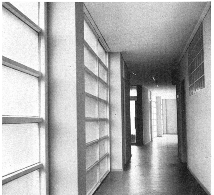
Corridor vitré; éléments de béton préfabriqués | Verglaster Gang; vorgefertigte Betonrahmen | Glazed corridor
