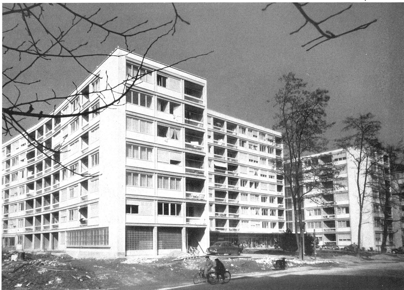
Vue générale prise du sud | Gesamtansicht aus Süden | General view from south
