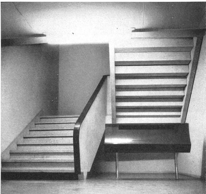
Escalier monté d'éléments préfabriqués | Treppe aus vorgefertigten Betonelementen | Staircase made of prefabricated concrete elements
