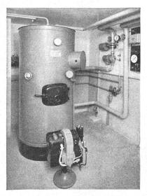
Kombinierte Ausführung für Heizung und Warmwasserbereitung
