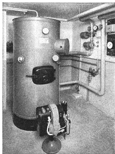
Kombinierte Ausführung für Heizung und Warmwasserbereitung
