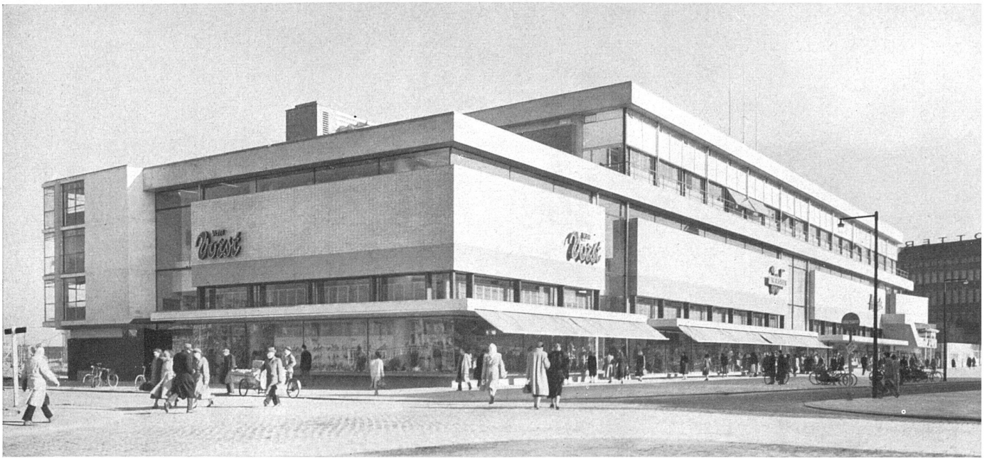
Gesamtansicht | Vue générale du grand magasin | General view of the department store
