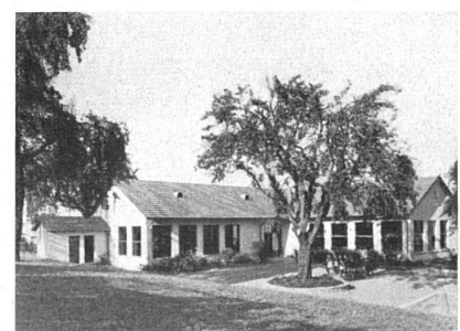
Kindergarten in der Siedlung Im Roßweidli, 1944. Robert Winkler, Arch. BSA
