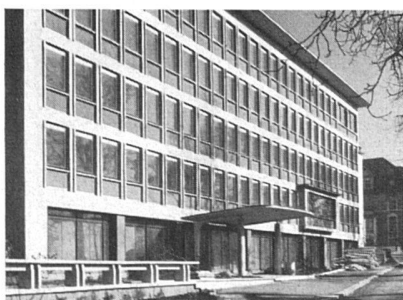
Erweiterungsbau des Physikalischen Institutes der ETH, Zürich, Gloriastraße, 1950. L. Boeckler und F. Metzger, Arch. BSA
