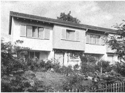
Wohnkolonie Eigenheime am Stettbach, Zürich-Schwamendingen, 1945/46. G. P. Dubois und J. Eschenmoser, Arch. BSA
