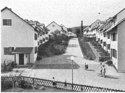
Wohnsiedlung «Sunnige Hof», Zürich-Schwamendingen, 1943. K. Kündig, Arch. BSA
