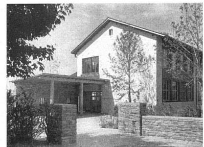
Schulhaus Triemli C, Triemlistraße 45, Zürich-Albisrieden, 1944/45. E. und B. Witschi, Arch. BSA
