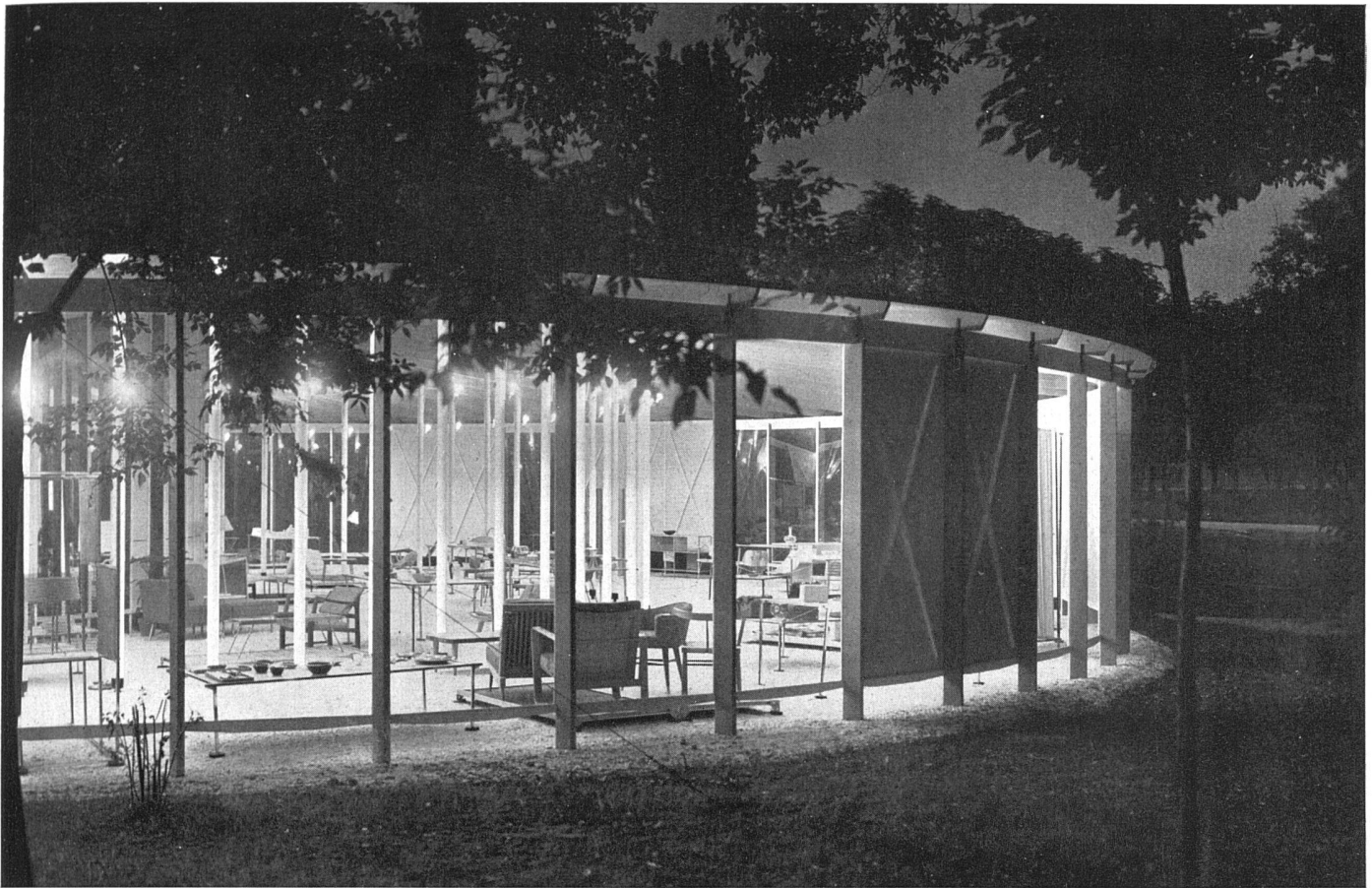
Pavillon der Vereinigten Staaten von Nordamerika, eingerichtet vom Museum of Modern Art, New York. Bau: Architekten L. Belgiojoso, E. Peressutti, E. Rogers, Mailand | Pavillon des Etats-Unis | American Pavilion
