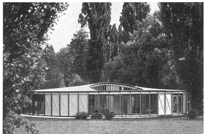
Pavillon der USA aus Holz und Glas mit exzentrischem rundem Innenhof, nach welchem das Dach leicht ansteigt | Pavillon des Etats-Unis | American Pavilion
