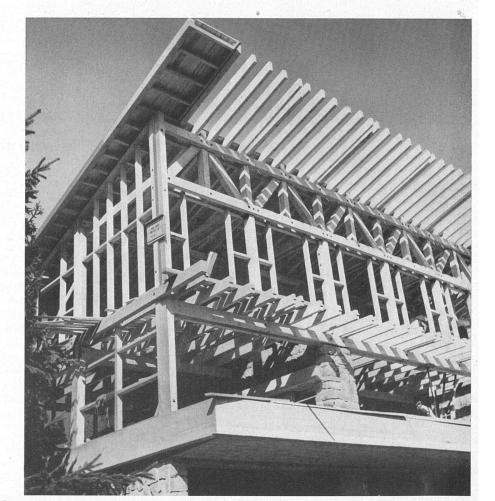
Das Haus im Bau. Am Längsträger unter dem Dachvorsprung hängt die Decke des Erdgeschosses | La maison en chantier. A la poutre longitudinale de l'avant-toit s'accroche le plafond du rez-de-chaussée | The house under construction. The ceiling of the ground floor is suspended from the roof truss
