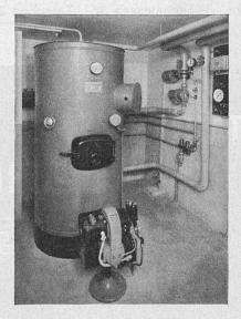
Kombinierte Ausführung für Heizung und Warmwasserbereitung
