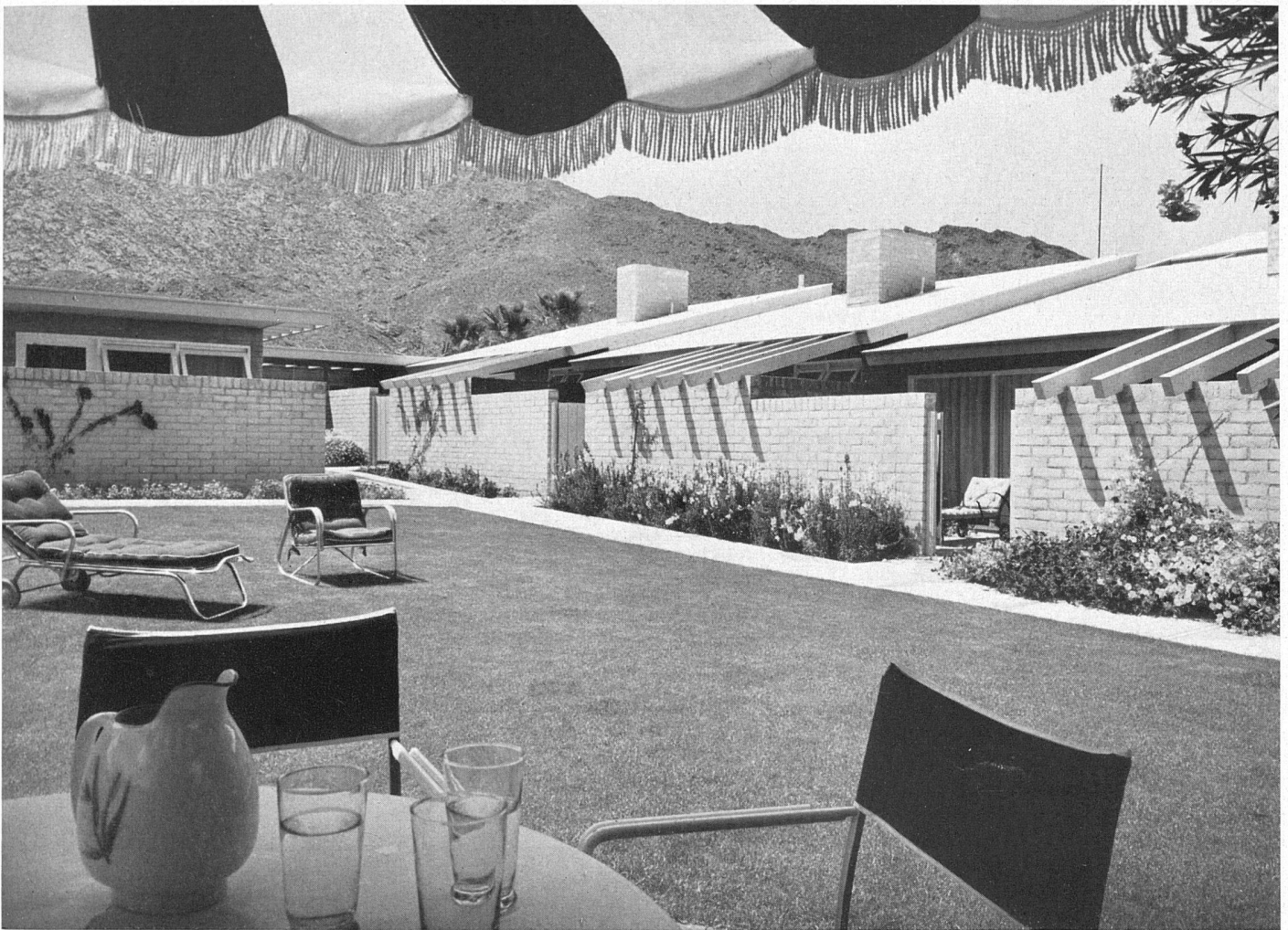
Die vermietbaren Ateliers vom Gartenhof gesehen | Façade sud des studios / South elevation of the rented studios
