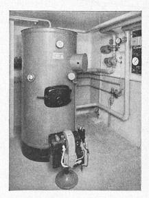
Kombinierte Ausführung für Heizung und Warmwasserbereitung
