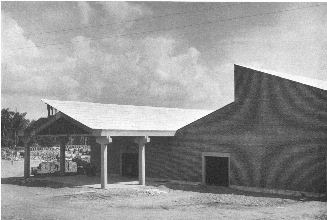
Ansicht der Giebelfront mit Anfahrt | Façade à pignons et entrée des voitures | View of gabled front with approach
