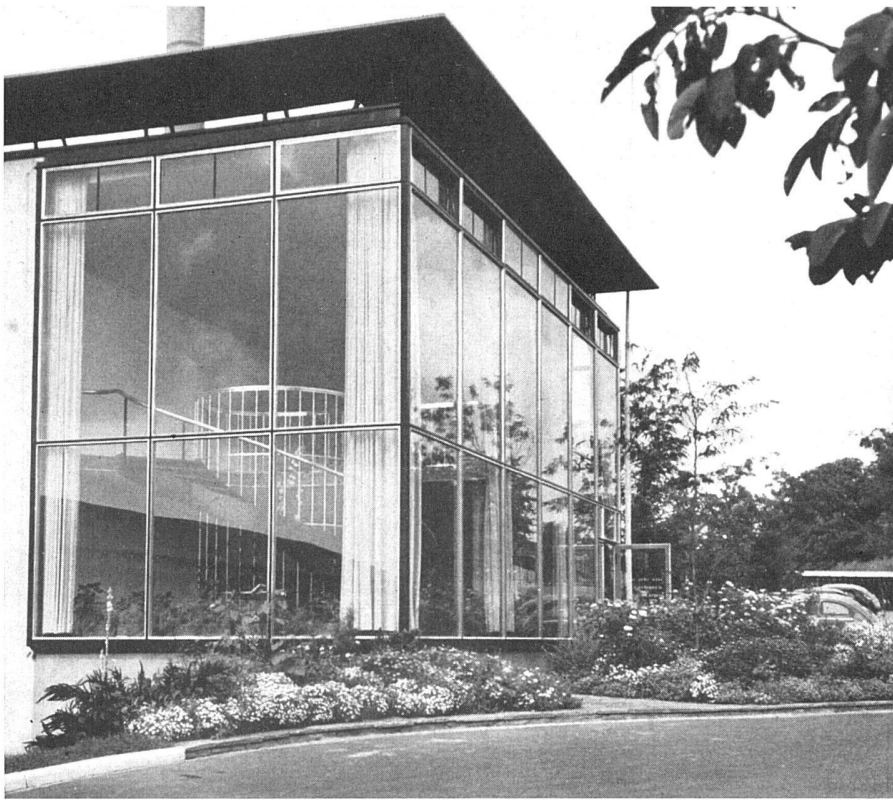
Der durchsichtige Kopf des Zentralgebäudes. Schwarze und dunkelblaue Eisenkonstruktion mit Glasleisten in Aluminium | Le front du bâtiment central est transparent. Construction en fer noir et bleu sombre avec filet de vitrage en aluminium | Transparent front of central building. Black and dark-blue iron structure with window framework in aluminium
