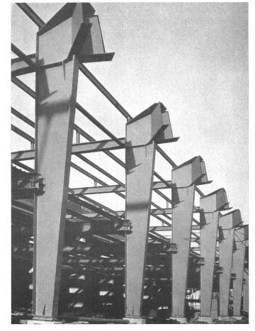
Die Halle im Bau. Ständer mit Bogenansätzen. Links Verbindungsbau zur Halle I | La halle en construction. Piliers avec retombée des arcs. A gauche galerie de liaison avec la halle I | Hall under construction. Stanchion's with arch supports; on left, gallery communicating with Hall I Photo: Ateliers de Constructions Mécaniques de Vevey S.A.
