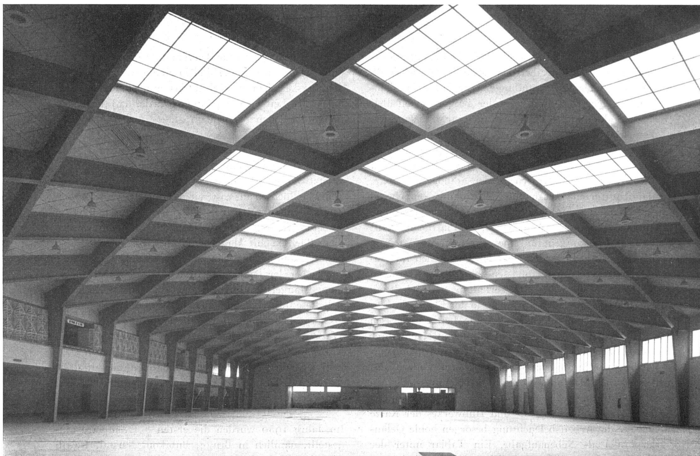
Innenansicht mit sichtbarer Durchdringung von zwei Rahmensystemen | Vue de l'intérieur de la halle montrant la compénétration de deux systèmes de chassis | Interior showing interpenetration of two frame systems
