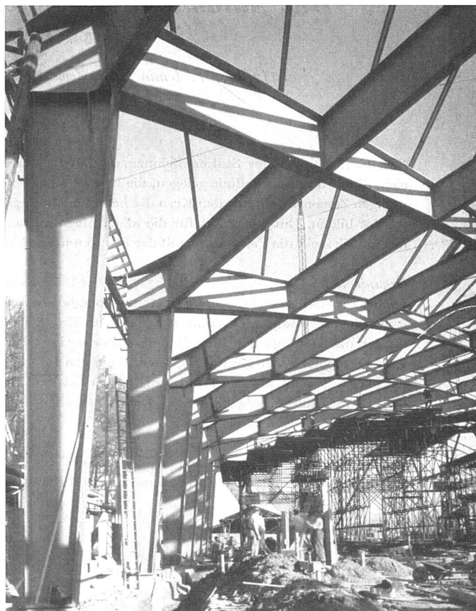
Ständer mit verschweißten Bogenstücken | Piliers avec les tronçons d'arc soudés | Stanchions with welded arch sections Photo: Constructions Métalliques Zwahlen & Mayr S.A., Lausanne
