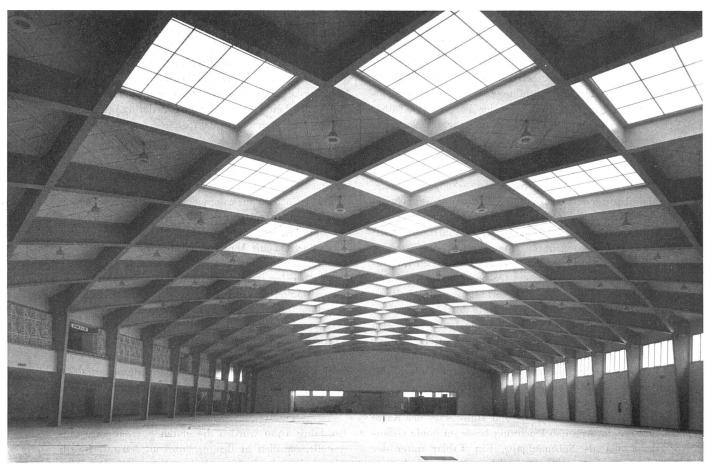
Innenansicht mit sichtbarer Durchdringung von zwei Rahmensystemen | Vue de l'intérieur de la halle montrant la compénétration de deux systèmes de chassis | Interior showing interpenetration of two frame systems
