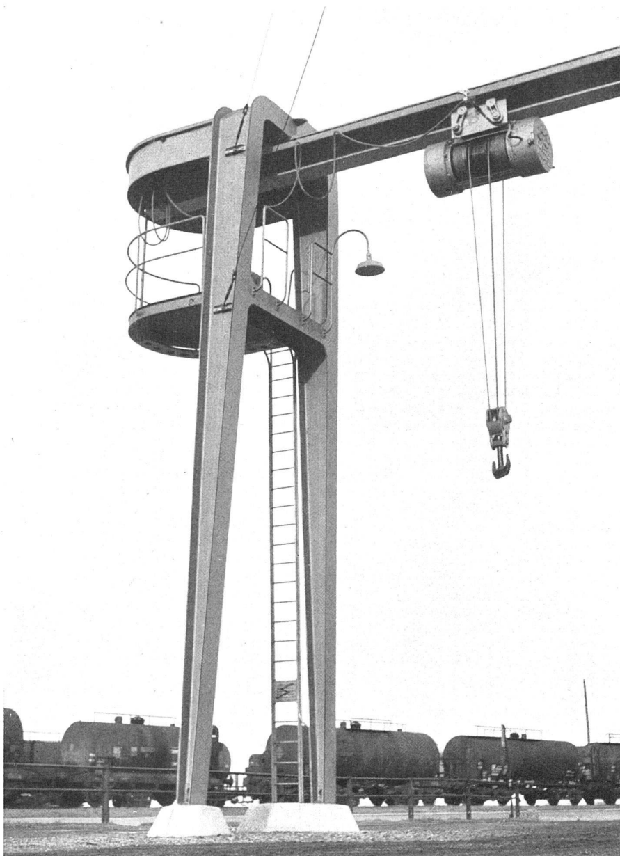
Straßenseitiger Ständer, Schenkel aus aufgeschnittenem und umgekehrt zusammengeschnittenem Din-Profil | Support du côté de la route, piliers en profil Din, fendu obliquement, retourné et soudé | Support near road, legs consisting of Din sections cut, reversed and rewelded
