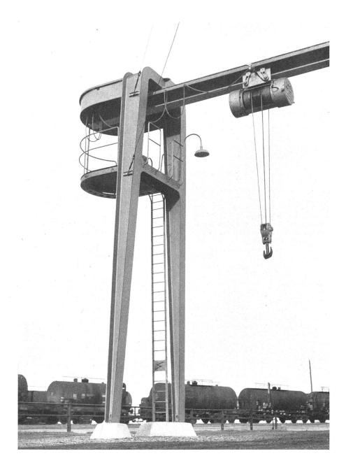
Straßenseitiger Ständer, Schenkel aus aufgeschnittenem und umgekehrt zusammengeschweißtem Din-Profil | Support du côté de la route, piliers en profil Din, fendu obliquement, retourné et soudé | Support near road, legs consisting of Din sections cut, reversed and rewelded
