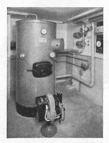
Kombinierte Ausführung für Heizung und Warmwasserbereitung
