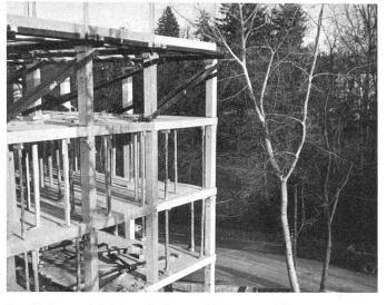
Das Skelett, vorfabrizierte Säulen und Unterzüge | L'ossature se compose d'éléments préfabriqués | The skeleton made of prefabricated concrete elements
