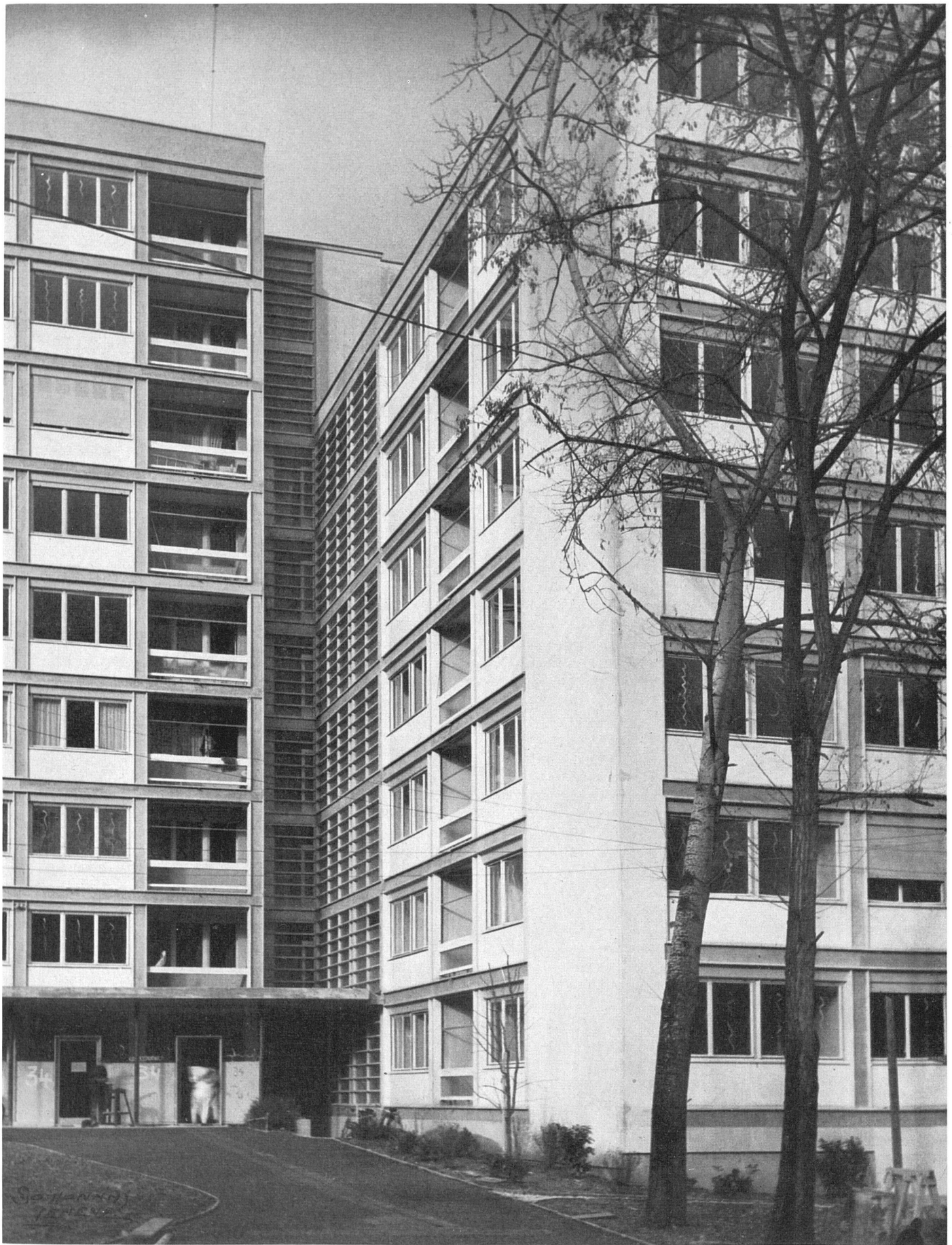
Teilansicht des nahezu vollendeten Wohnbaus. Sämtliche Fassadenelemente sind vorfabriziert: Säulen und Unterzüge aus geschliffenem Eisenbeton, Brüstungen und Wandungen aus geschliffenem Kunststein | Le bâtiment presque achevé. Les éléments de la façade sont tous préfabriqués en béton et pierre artificielle polis | The nearly completed building. The elements of the exterior are all prefabricated (polished concrete and artificial stone)
