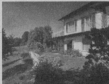
Wohnhaus Dir. J. in Reinach Architekt: Hermann Baur BSA, Basel
