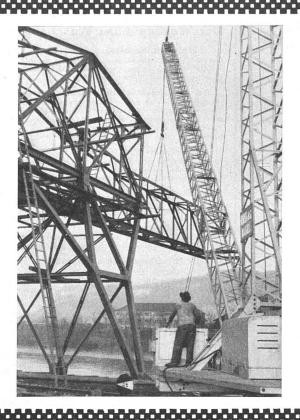
Montage der Stahlkonstruktion einer Entladeanlage für Brikettbündel im Auhafen Basel. Mühelos hebt der Derrik Lasten bis zu 15 tund bringt wie hier ganze Brückenteile an Ort und Stelle.
