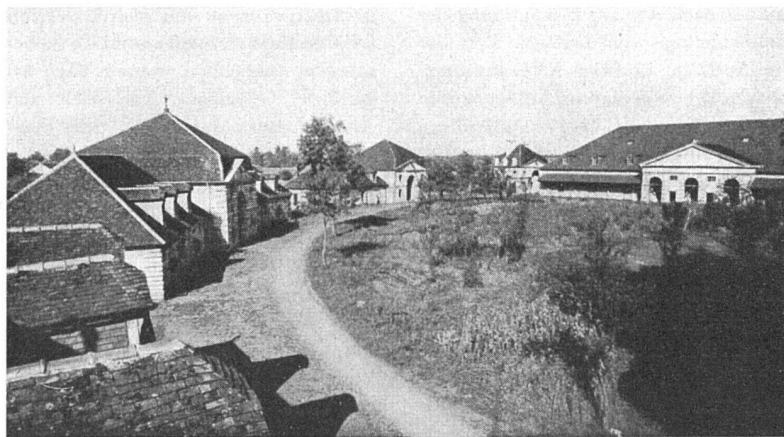
Blick in die Anlage: Handwerkerhäuser und Destillationshalle. Abbildungen nach: Marcel Raval, Claude-Nicolas Ledoux, Paris 1945
