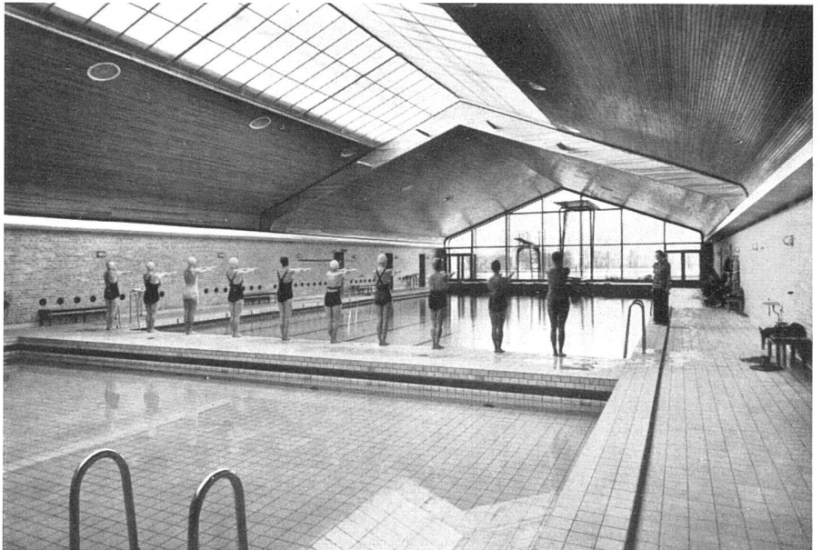
Schwimmbassin geschlossen, im Vordergrund Nichtschwimmerbassin | Piscine avec toit fermé | Swimming pool with closed roof, in foreground the nonswimmers pool
